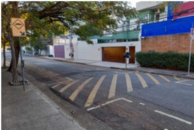
↑ San Pablo, Brasil. Los reductores de velocidad en asfalto deben seguir estándares adecuados de geometría, señalización horizontal y vertical para cumplir su función, pero sin causar problemas derivados de implementación. Imagen: German Freiberg.
