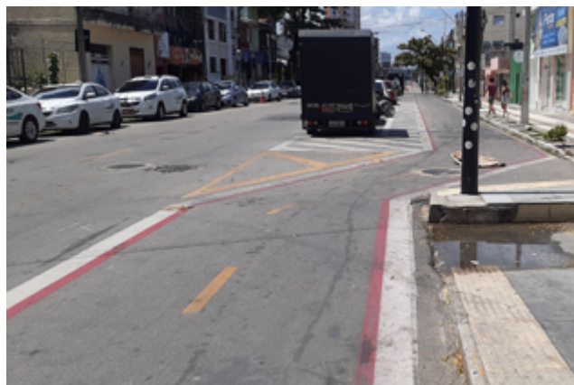
↑ Fortaleza, Brasil. Ciclovía bidireccional dedicada, con tramo protegido por franja de estacionamiento en la Av. Almirante Barroso. Imagen: Suzana Nogueira.
