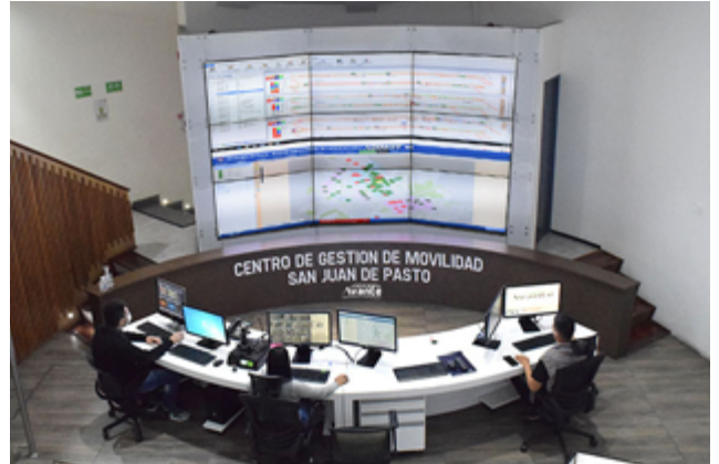
↑ San Juan de Pasto, Colombia. El Centro de Gestión de Movilidad integra el control del sistema semafórico, del sistema de gestión y control de flota, y del sistema de recaudo centralizado. 🔗 Imagen: https://avante.gov.co/nuestros-proyectos/
