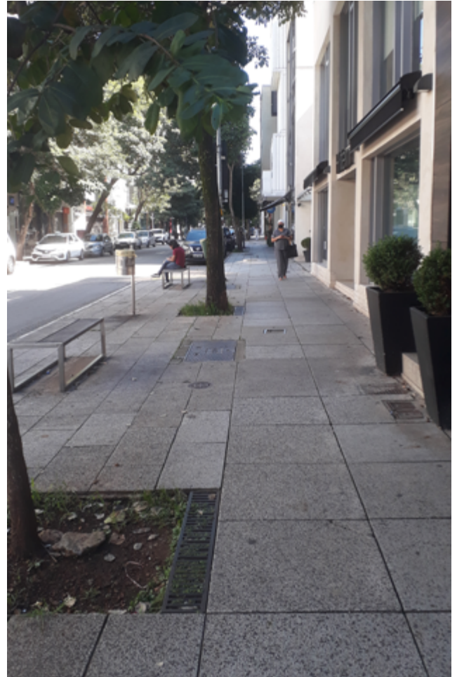
↑ San Pablo, Brasil. Recalificación de vereda en calle comercial Oscar Freire. A través de un acuerdo entre comerciantes y gobierno se hizo la recalificación de la calle Oscar Freire que incluyó retirada del área de estacionamiento vehicular para ampliación del espacio del peatón, cambio del pavimento de la vereda, instalación de mobiliario urbano, cambio de la iluminación con atención a la accesibilidad universal y soterramiento del cableado. Imagen: Mariana Novaski.
