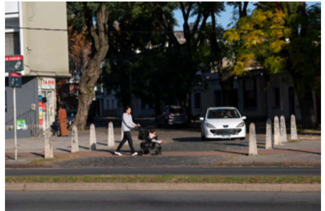
↑ Montevideo, Uruguay. Boulevard Artigas, Prado: cruce elevado en intersección entre vialidad primaria y secundaria para mayor seguridad peatonal. Imagen: Diego Battiste.
