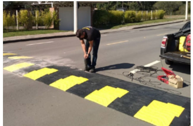
↑ Teresina, Brasil. La implantación del reductor de velocidad (lomo de burro) es recomendable cuando se desea bajar la velocidad vehicular. Es posible implementar el reductor de velocidad a partir del reciclaje de materiales, en el caso de Teresina lo hicieron con restos de neumáticos. Imagen: https://strans.pmt.pi.gov.br/2020/01/22/teresina-tera-a-primeira-lombada-ecologica/
