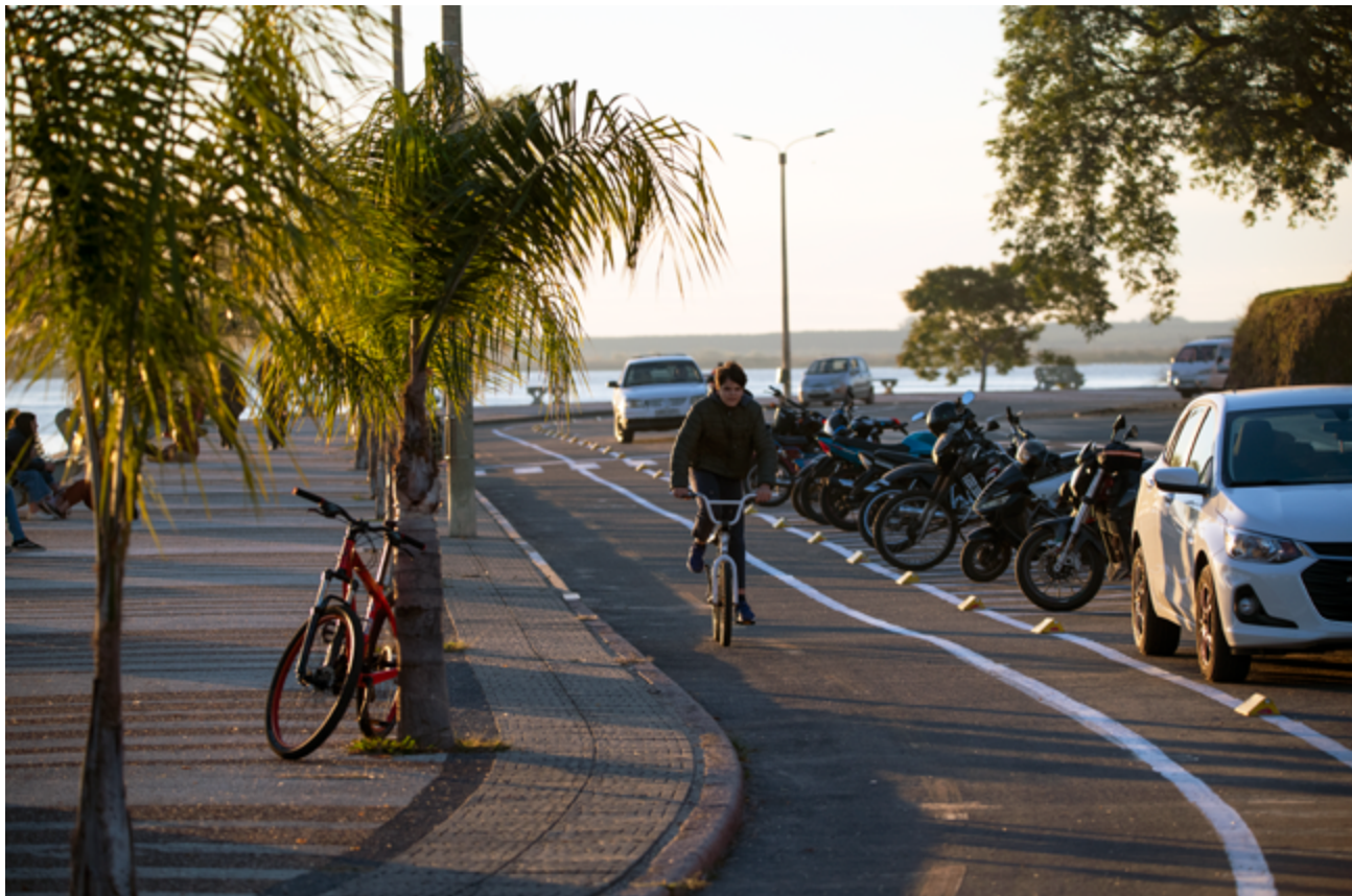
↑ Fray Bentos, Uruguay. Rambla. Ciclovía bidireccional segregada entre estacionamiento vehicular y vereda. Imagen: Diego Battiste.
