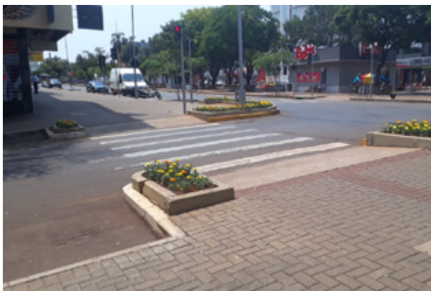
↑ Cascavel, Brasil. Extensión de vereda junto al cruce en Av. Brasil: reducción de la distancia de cruce para los peatones, eliminación de estacionamiento vehicular irregular cerca del cruce y reducción de la velocidad vehicular en el giro aumentando la seguridad. Imagen: Mariana Novaski.
