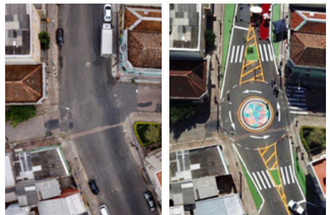
↑ Porto Alegre, Brasil. Rotonda en la Calle João Alfredo. Antes y después de la implementación de una rotonda en la calle João Alfredo con urbanismo táctico. La rotonda obliga la disminución de velocidad vehicular y evita las colisiones frontales. Imagen: Daniel Kener Neto.
